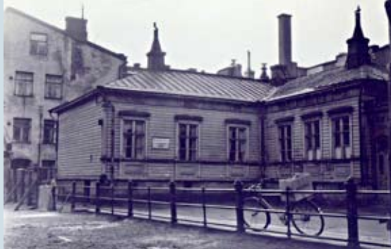
Kansakoulukuja 3. Ennen rakentamisen aloittamista.
